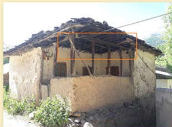
(تصاویر شماره ۲ و ۳ - استفاده از چوب به عنوان ستون و سرستون)
