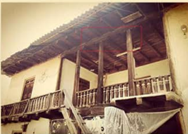
(تصاویر شماره ۲ و ۳ - استفاده از چوب به عنوان ستون و سرستون)
